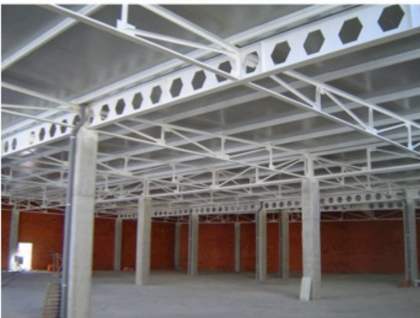
Estruturas metálicas ou madeira
